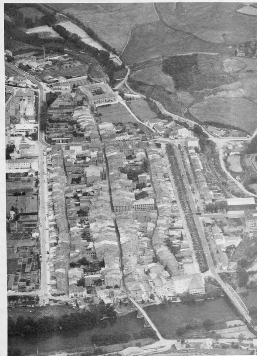
Ph. 4. PUENTE LA REINA : Vue aérienne oblique.
