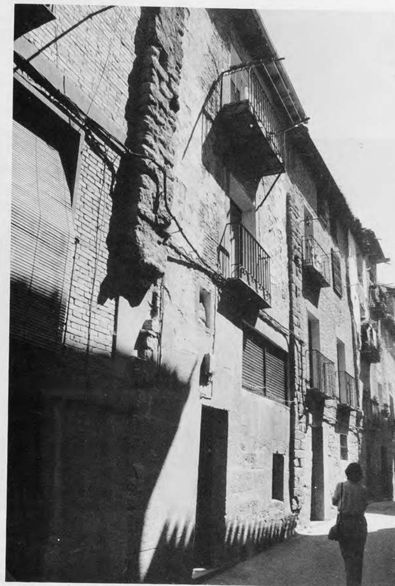
Ph. 17. VIANA : Rue secondaire est-ouest, murs mitoyens.
