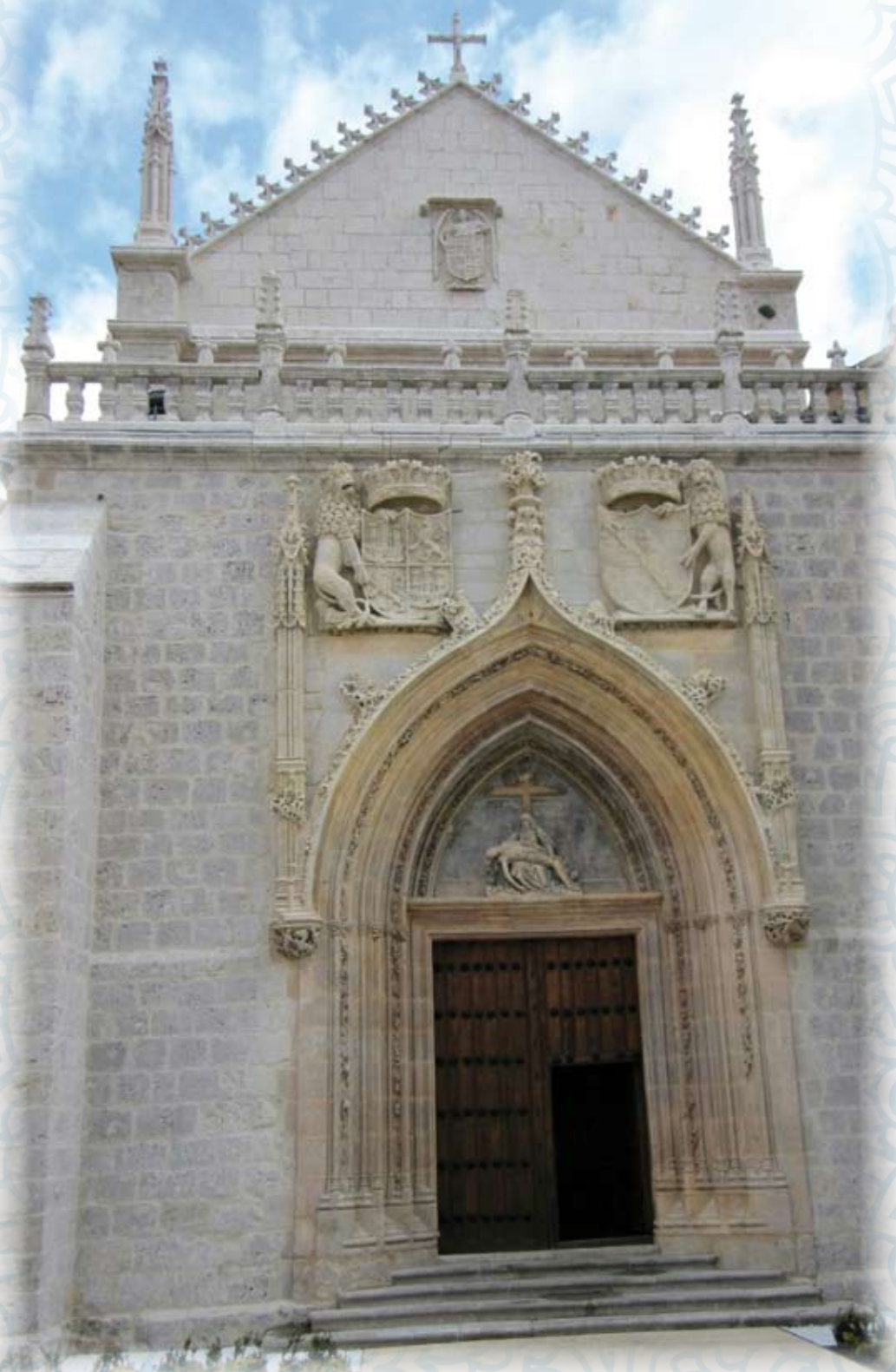
PORTADA DE ACCESO A LA IGLESIA. CARTUJA DE MIRAFLORES. BURGOS
