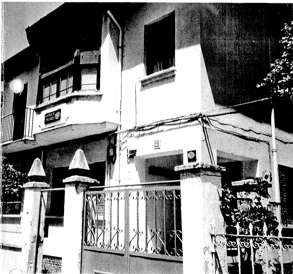
Edificio del albergue
