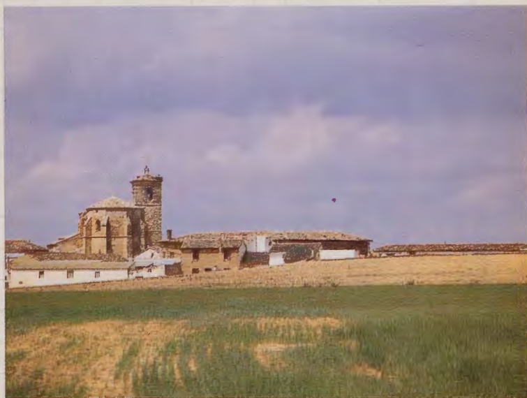
Vista Boadilla del Camino
