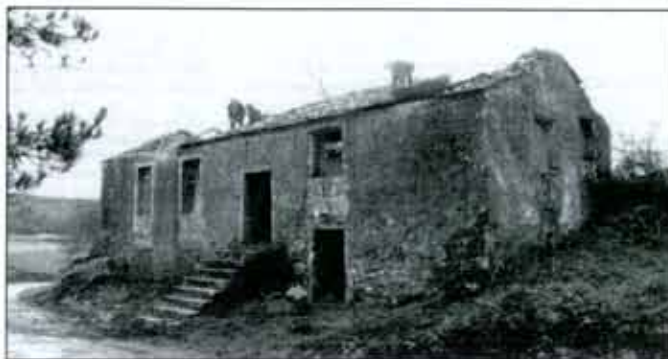
Trabajos en la antigua escuela de Ligonde
