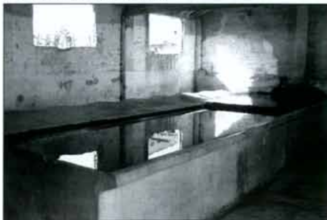
Interior lavadero en calle de las Cercas.
