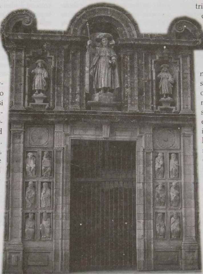
Puerta santa o de los perdones
